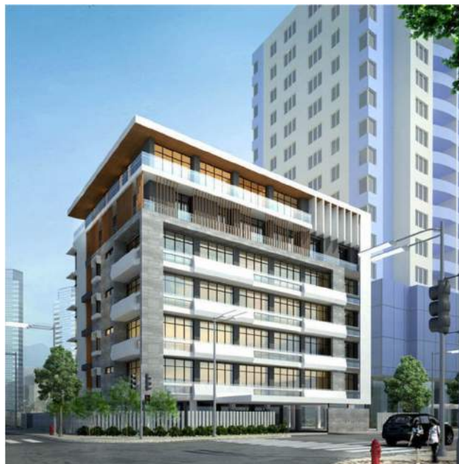
TRỤ SỞ BỘ XÂY DỰNG CN PHÍA NAM
