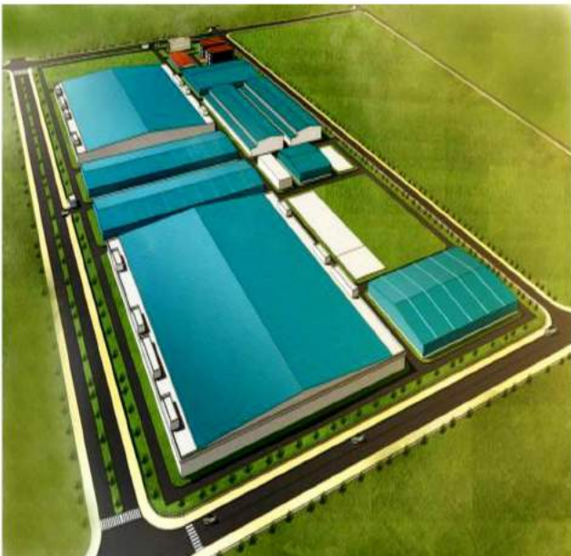
NHÀ MÁY SỢI HUAFU
