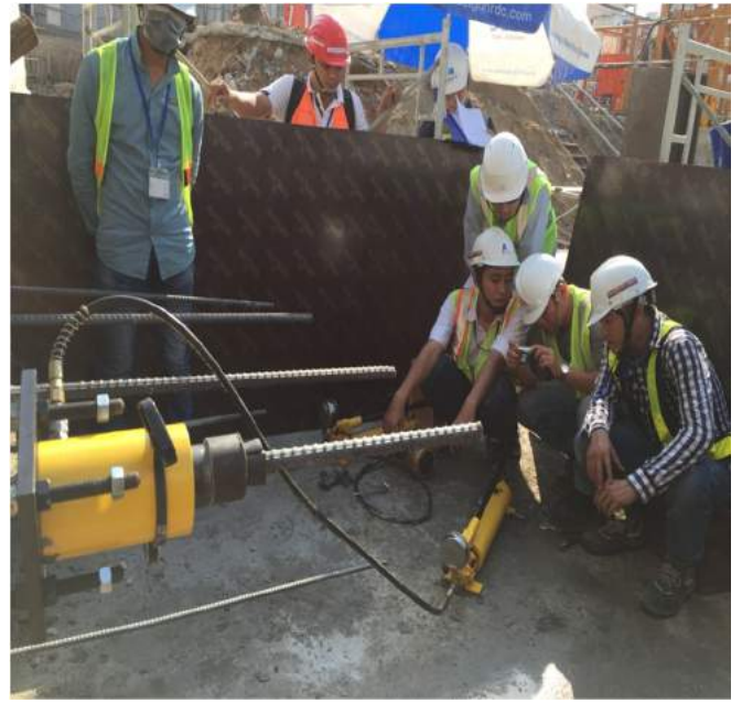
THỬ NHỒ THÉP KHOAN CÂY
