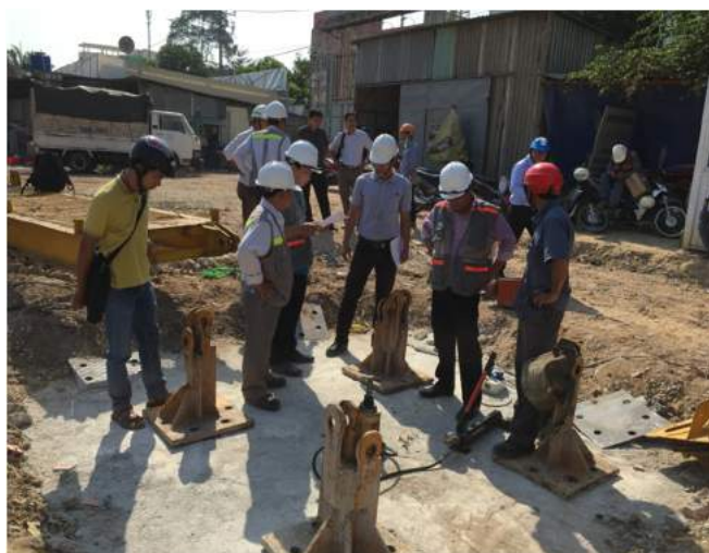
THỬ NHỎ BULONG MÓNG CẦU THÁP
