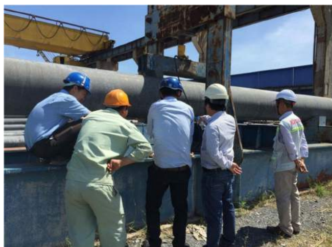
THỬ UỐN NỨT CỌC
